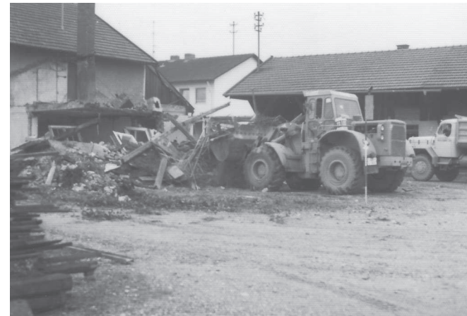
Abriss des alten Wohnhauses
