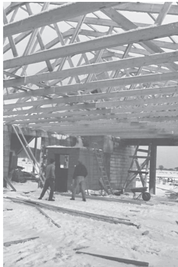
Bau des Maschinenraums
